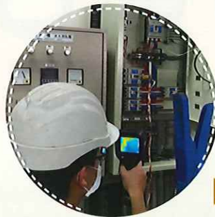
電力盤熱點量測
